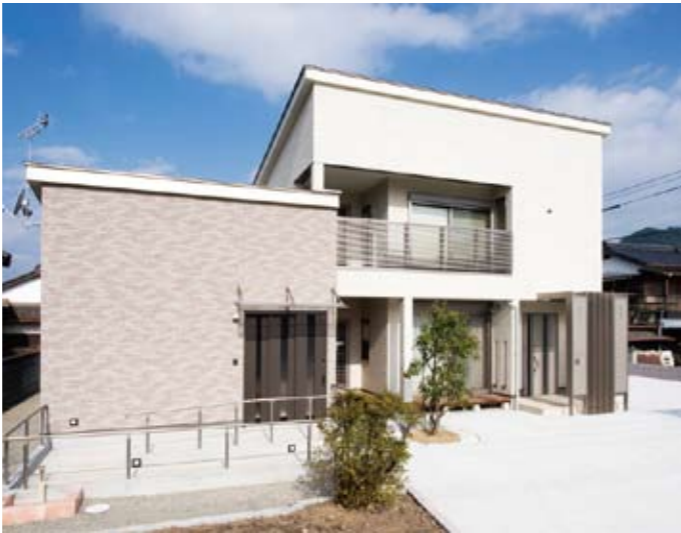
いくつもの立方体を組み合わせた外観は、屋根の傾斜がアクセントとなっている。玄関のほかに、車椅子で出入りできるための入り口も設けられている（E邸）
