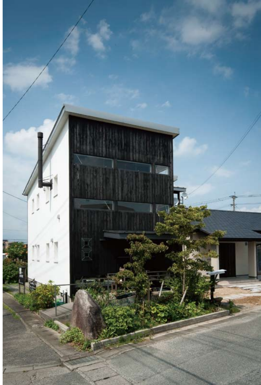
ギャラリーと自宅が併設したS邸。スクエアを基本としたキューブ型の外観に、片流れの屋根がアクセントを加えている。壁面の白は漆喰、黒は天然木と自然の質感を活かしたモダンな仕上げ。自宅は伝統の平屋造り。少数精鋭で施工力に定評がある同社はどちらも得意分野だ（S邸）
