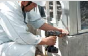
成型されたBPSフレームは、熟練したスタッフによって組み立てられる
